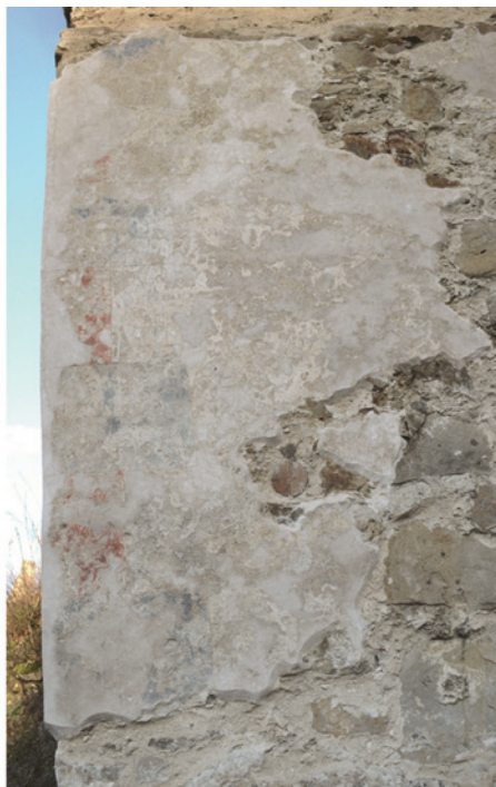
Kvádrovanie 1. np. ustúpenej západnej steny, stav po vytmelení.
