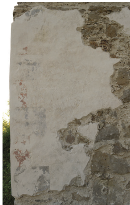
Kvádrovanie 1. np. ustúpenej západnej steny, stav po nanesení podkladového vápenného náteru.
