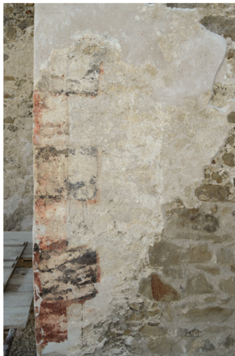
Kvádrowanie 2. np. predsunutej západnej steny, stav po vyčistení
