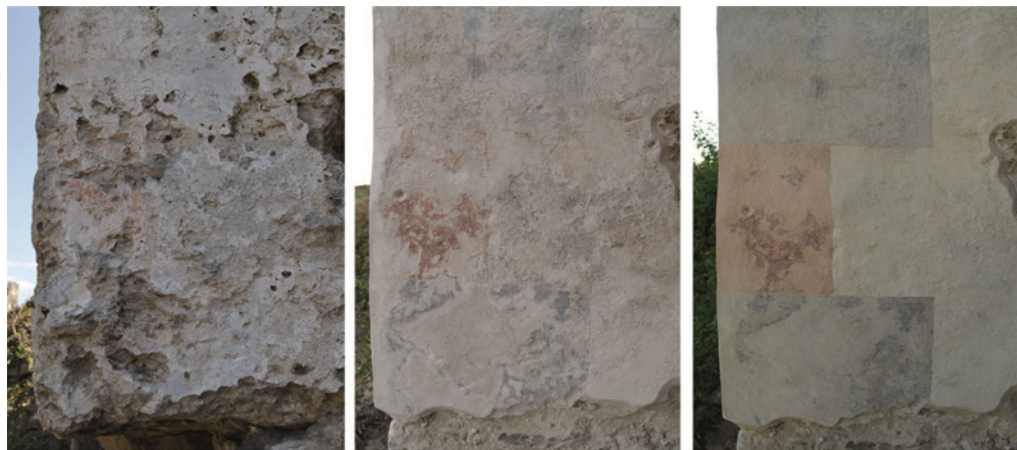
Kvádrovanie 1. np. ustúpenej západnej steny, detail. Stav pred reštaurovaním, po vytmelení a po reštaurovaní.
