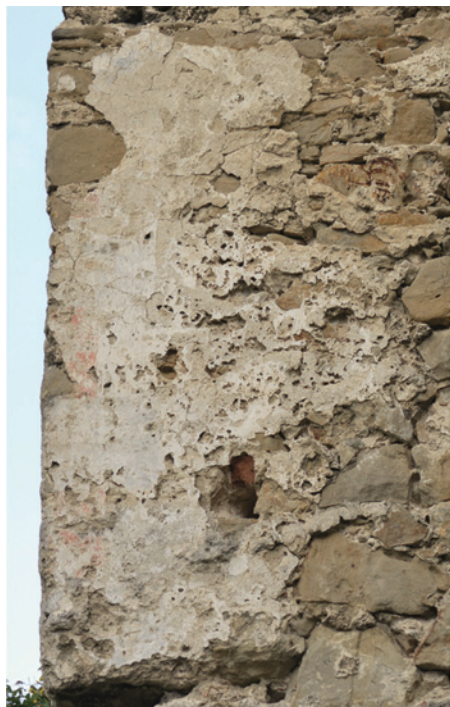
Kvádrovanie 1. np. ustúpenej západnej steny, stav pred reštaurovaním.
