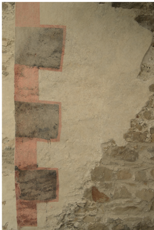
Kvádrowanie 2. np. predsunutej západnej steny, stav po reštaurovaní.
