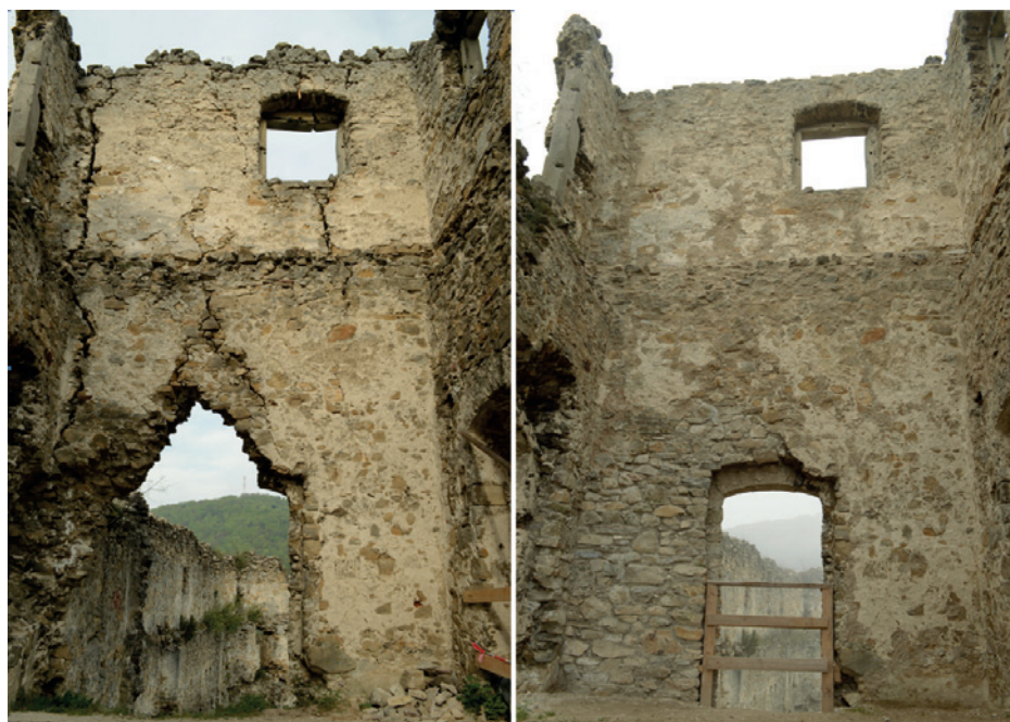
Obr. 8. Porovnanie stavu západnej strany východnej časti južného obytného krídla z interiéru, pred konzervovaním a reštaurovaním (2013) a po ňom (2014).
