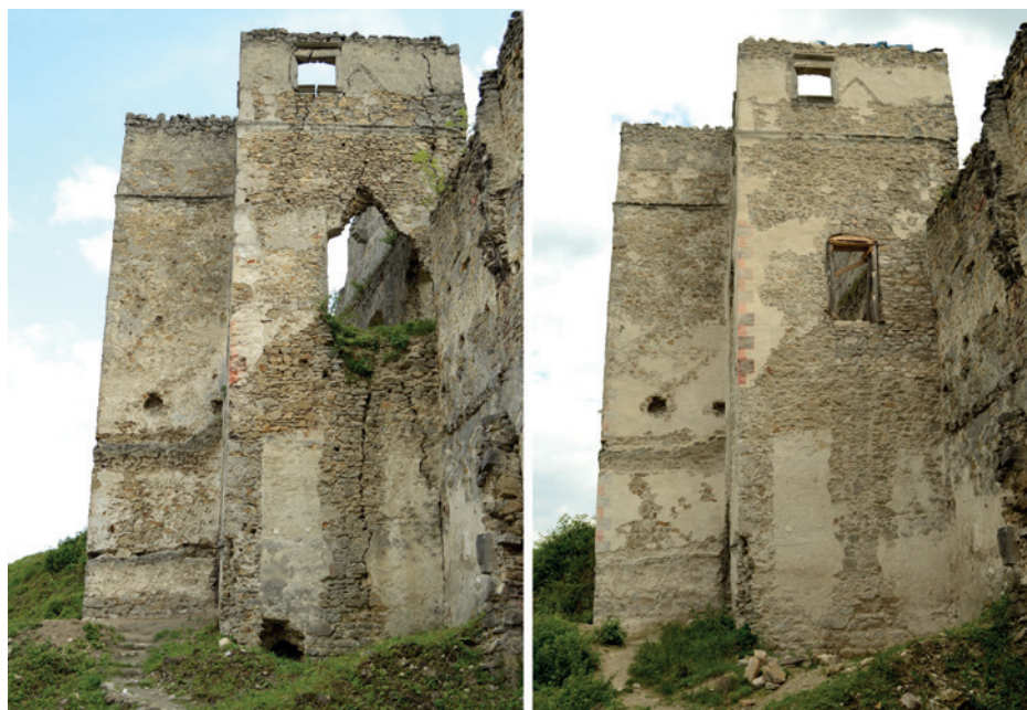
Obr. 7. Porovnanie stavu západnej strany východnej časti južného obytného krídla z nádvorja pred konzervovaním a reštaurovaním (2013) a po ňom (2014).
