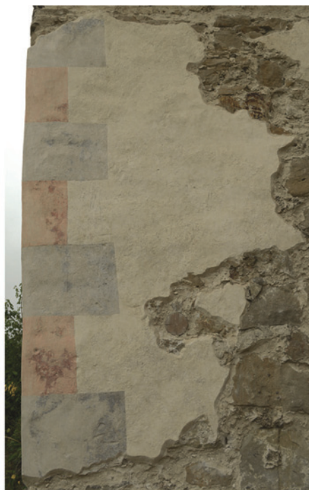
Kvádrovanie 1. np. ustúpenej západnej steny, stav po reštaurovaní.
