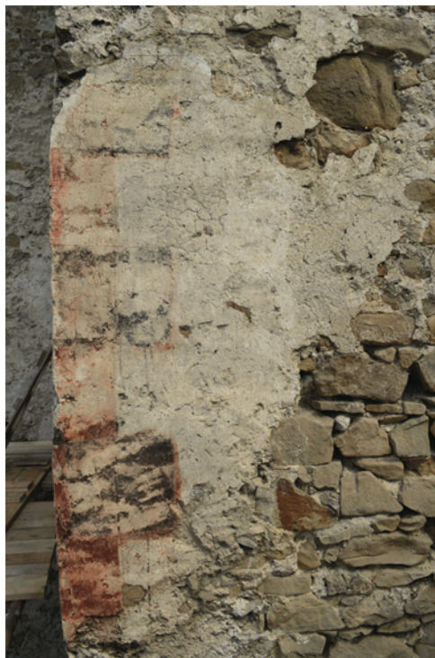
Kvádrowanie 2. np. predsunutej západnej steny, stav pred reštaurovaním.
